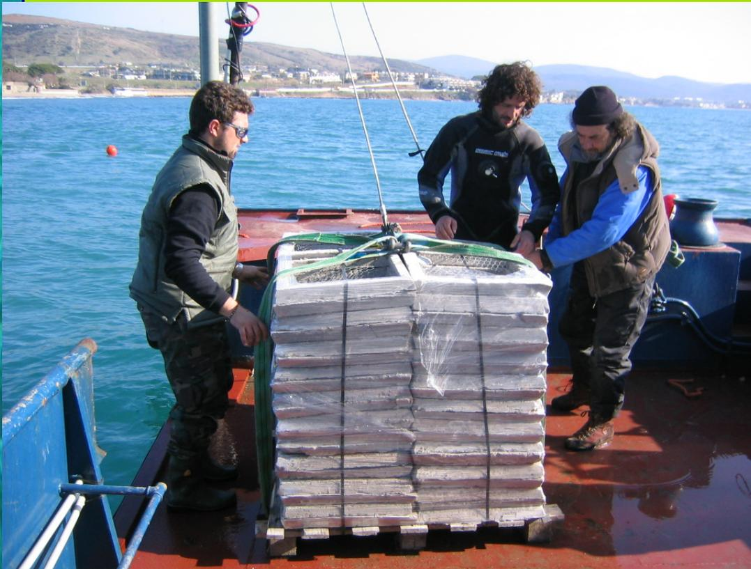
I moduli, sistemati in gruppi da 60 unità per pallets, sono stati caricati su un'ideale imbarcazione che ha provveduto al trasporto e all'immersione in mare a mezzo verricello idraulico nei siti di reimpianto
